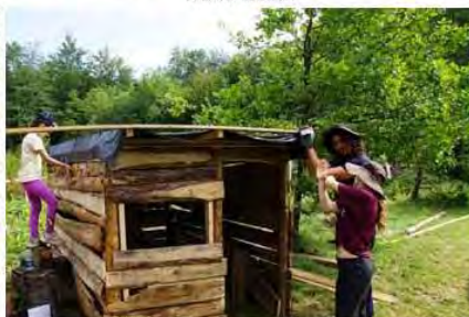
Der Hüttenbau geht weiter
