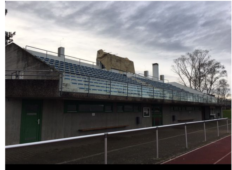
Die Tribüne im Stadion bekommt nächstes Jahr ein neues Dach
